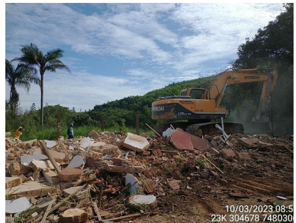
Foto 8 – Atividade de demolição na casa nº 5. (Data: 10/03/2023).
