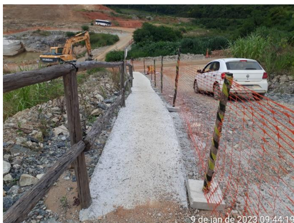
Foto 1 – Limpeza e organização para o caminho seguro referente acesso ao Canteiro de Obra. Data: (09/01/2023).
