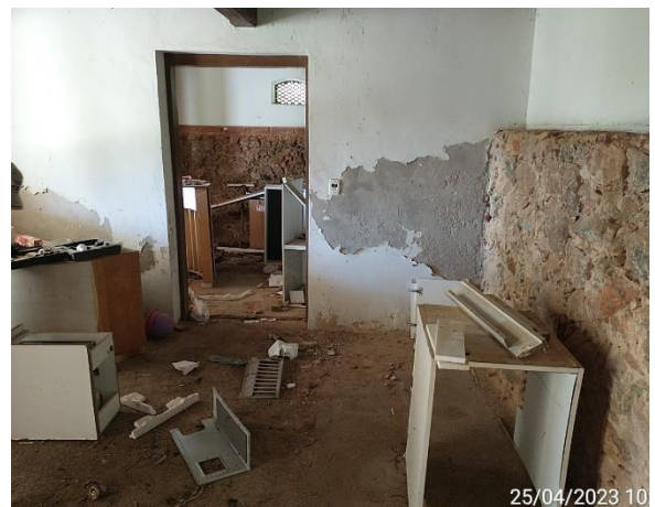
Foto 6 – Desmonte e retirada de móveis dos cômodos. (Data: 25/04/2023).
