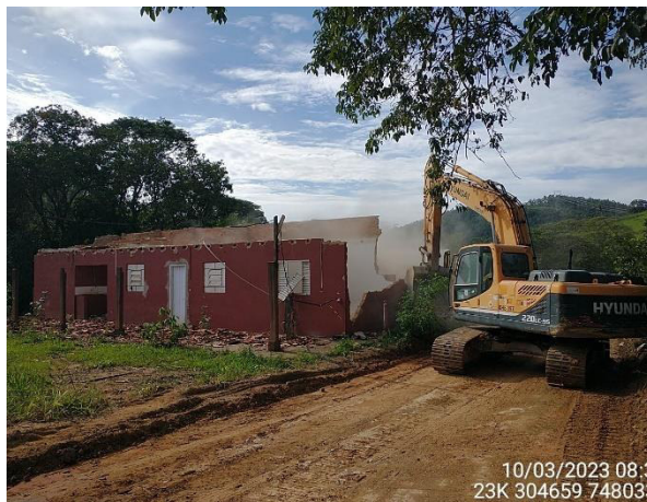
Foto 7 – Início da demolição. (Data: 10/03/2023).
