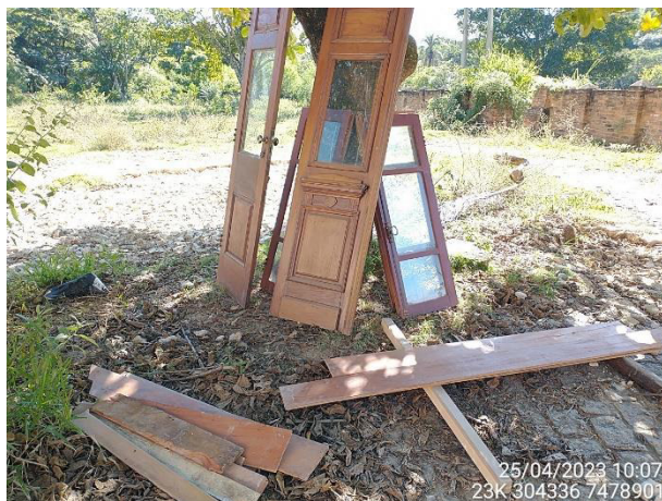
Foto 5 – Remoção de janelas e portas. (Data: 25/04/2023).
