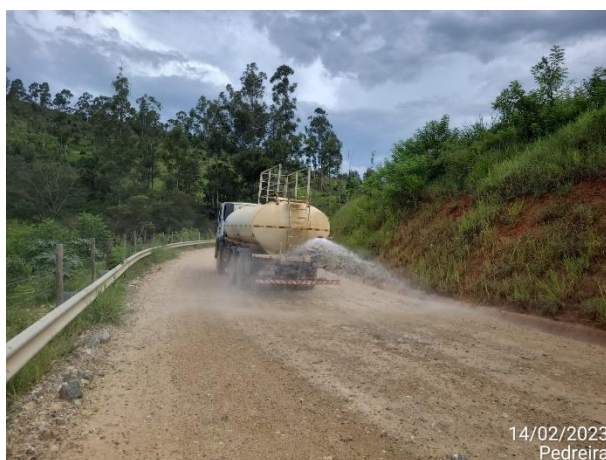
Foto 3 – Umectação realizada no acesso MD-03. Data: (14/02/2023).
