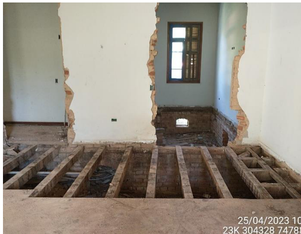
Foto 3 – Desmontagem dos pisos de madeira. (Data: 25/04/2023).
