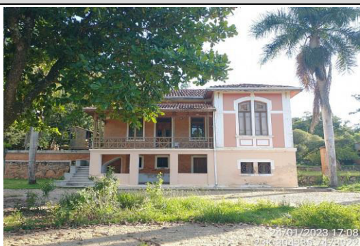
Foto 1 - Vista externa da casa 40.
